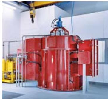
**PLUNGER.** Para Plunger L. & Sohn AG realizamos suministro, instalación y puesta en marcha de todo el equipo electromecánico de la central eléctrica, así como la planificación y gestión de la construcción. Dos turbinas Kaplan espirales de eje vertical con un caudal de agua total de 18.000 l/s y una caída de 16,5 m.
