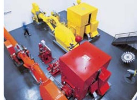
**RABENSTEIN.** Para Rabenstein Konsortial GmbH realizamos suministro, instalación y puesta en marcha de todo el equipo electromecánico de la central eléctrica. Turbina Pelton de cuatro inyectores y dos turbinas Francis con un caudal de agua total de 3.000 l/s y una caída de 130 m.
