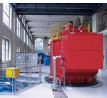
**OBERMATT.** Para EWL (Energie Wasser Luzern) realizamos suministro, instalación y puesta en marcha del equipo mecánico de la central eléctrica, incluyendo los reguladores de turbinas. Turbina Pelton de cuatro inyectores con un caudal de agua de 3.024 l/s y una caída de 309 m.
