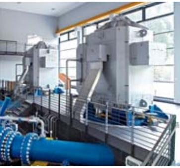
**REINBACH.** Para Tauferer Elektrowerk AG realizamos suministro, instalación y puesta en marcha de todo el equipo electromecánico de la central eléctrica. Dos turbinas Pelton de cuatro inyectores con un caudal de agua total de 4.800 l/s y una caída de 416 m.
